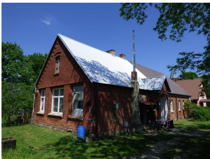
Fot. 25. Szkoła, ob. dom mieszkalny w Pstrowicach
